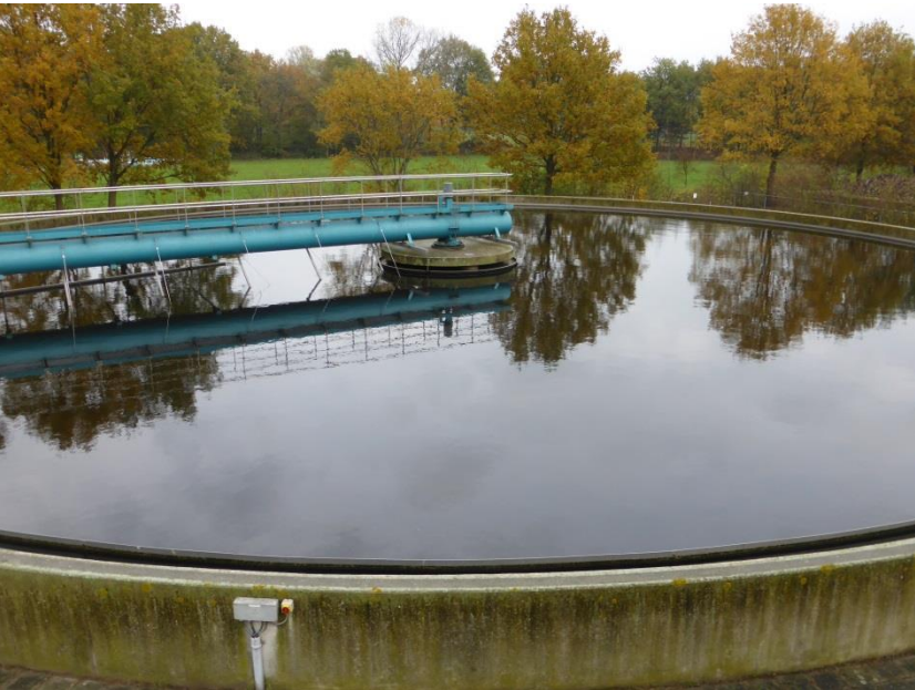
figuur 44 Nabezinktank op RWZI Woudenberg
